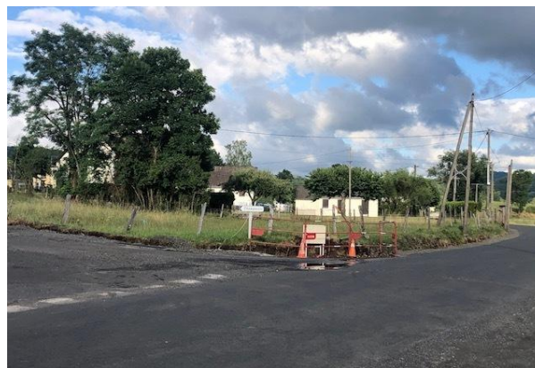
Travaux à et Champagnadoux
