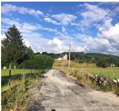
Travaux à Cheyssac
