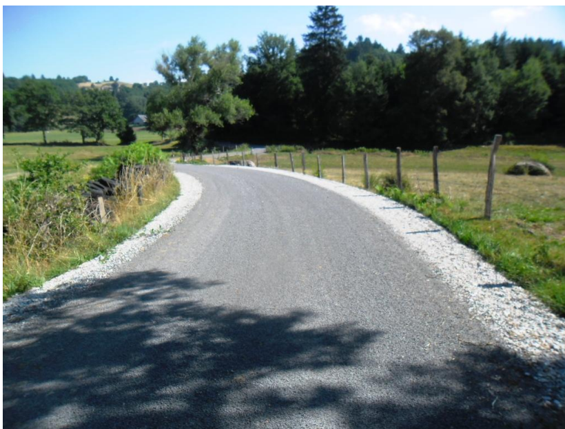
Rénovation de la voirie à Couzan
